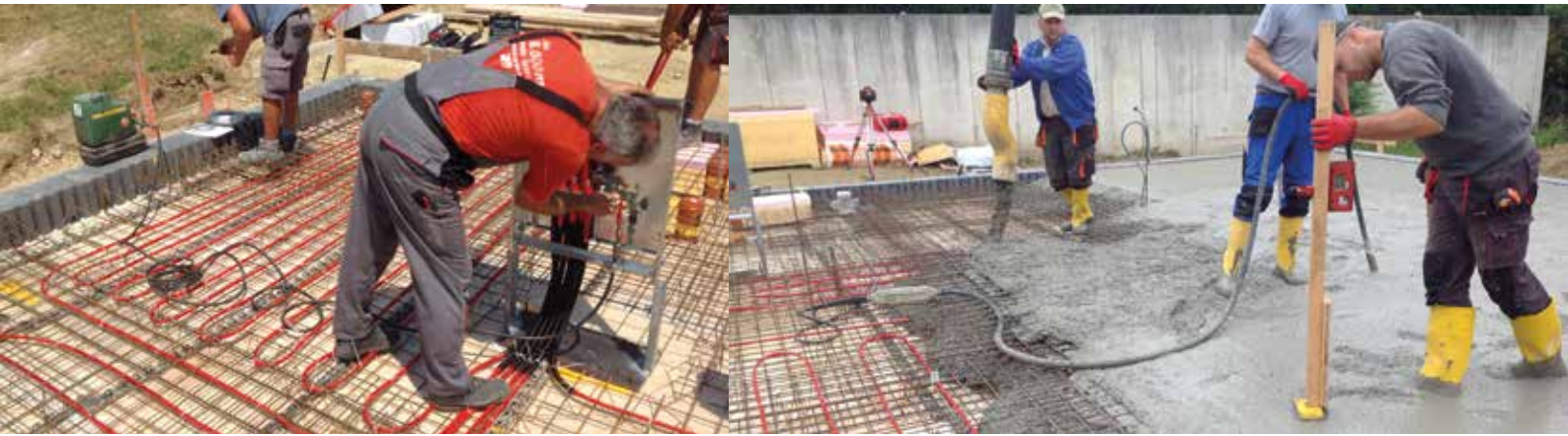
Ausführungsbeispiele der Thermischen Bauteilaktivierung: Montage der Rohrleitungen, Druckprüfung und Betonieren der Decke.
