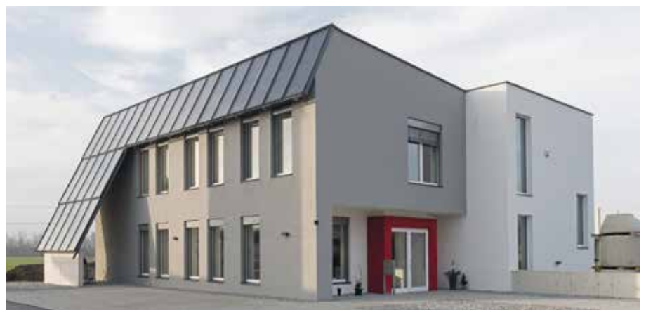
Abb. 13 | oben und rechts Solarthermische Anlage auf der Kletterhalle Saalfelden und auf dem Bürogebäude Hörfarter. © Z + B/Wild & Team; © Wolfgang Hörfarter/Hans Osterauer
