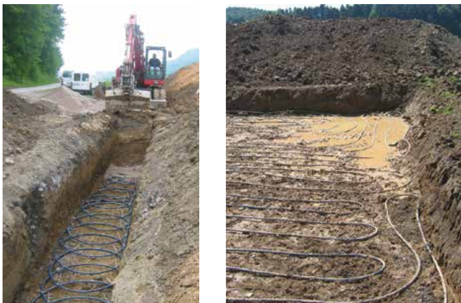
Abb. 37 | Ausführungsbeispiele von Erdkollektoren.
