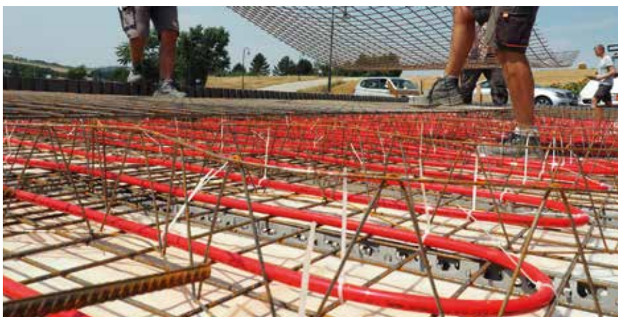
Abb. 17 | Verlegte Heizkreise in der Decke eines Einfamilienhauses in Niederösterreich.
