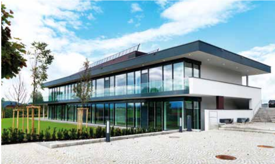
Abb. 18 | Beispiel zur Systemvariante 1 – Energieversorgung über Solarthermie, Gemeindezentrum Hallwang. © Adrian Kuster, Millstatt
